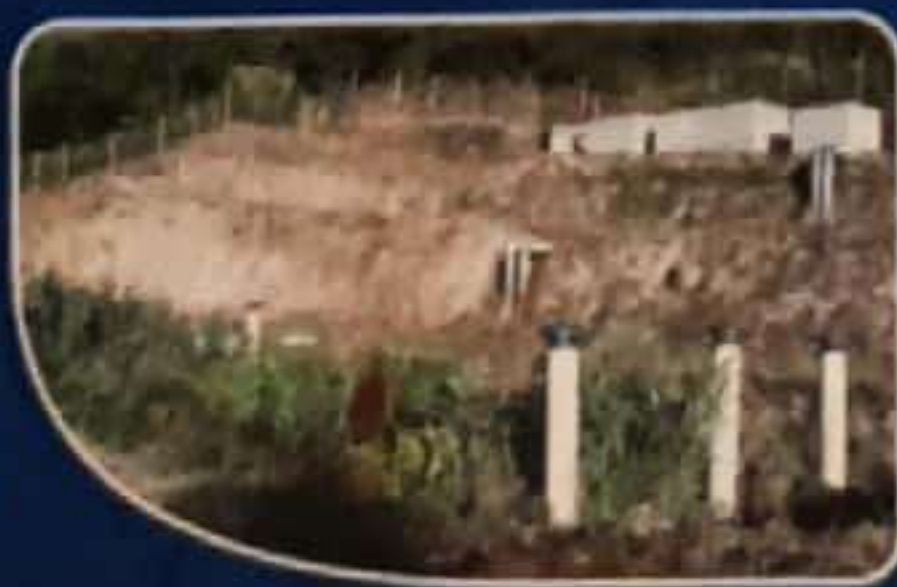
Station d'épuration sur lit à macrophytes de Noceta (Haute-Corse)
