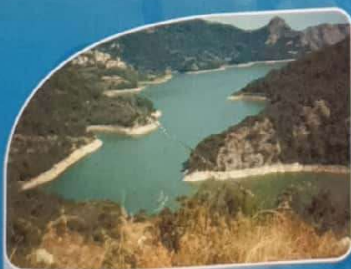
Barrage de Todda
