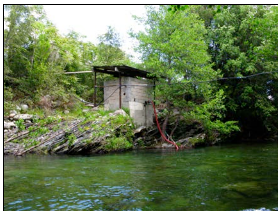
Figure 10 : Pompage individuel dans le lit du Tavignano. 2 juin 2010. MRM
