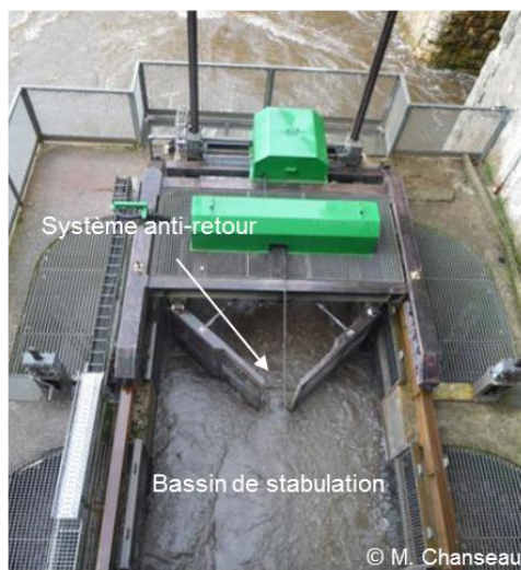
FRANCE 2 : DORDOGNE – TUILIERES : (de haut en bas et de gauche à droite) : vue aérienne de l'aménagement de Tuilières sur la Dordogne ; vue aval de l'usine, de l'ascenseur et du barrage ; vue de l'ascenseur ; vue du bassin de stabulation de l'ascenseur et du système anti-retour ; vue de la passe à bassins dans laquelle les poissons sont déversés
