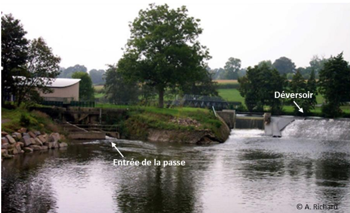
FRANCE 8 : VIRE – CLAIES DE VIRE : (de haut en bas) : vue aérienne de l'ouvrage de Claiés de Vire sur la Vire et de l'entrée de la passe à bassins.
