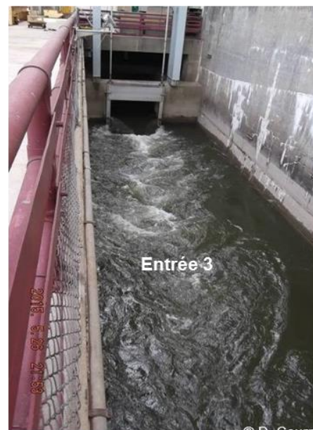
ÉTATS-UNIS 3 : SUSQUEHANNA – SAFE-HARBOR : (de haut en bas et de gauche à droite) : vue aérienne de l'ouvrage de Safe Harbor sur la Susquehanna et des trois entrées de l'ascenseur ; vue de l'usine depuis la rive gauche ; vue de l'usine depuis la rive droite ; vue des entrées 1 et 2 (abandonnée) ; vue de l'entrée 3.
