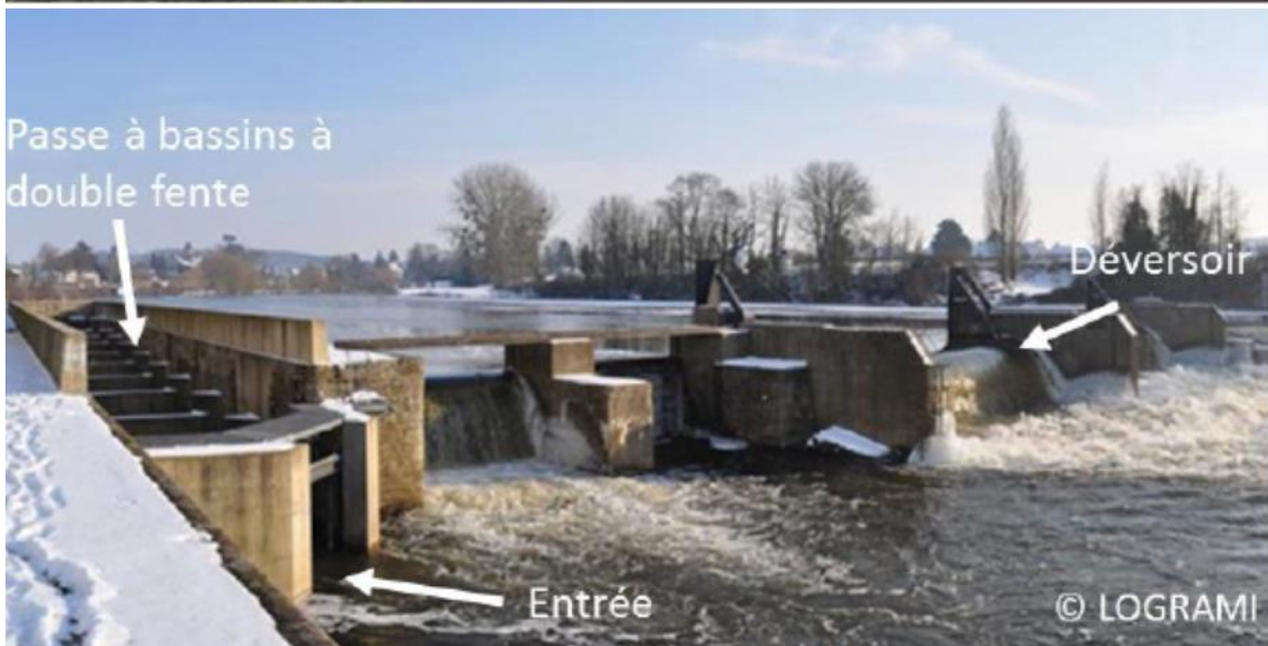
FRANCE 7 : CREUSE – DESCARTES : (de haut en bas) : vue aérienne de l'ouvrage de Descartes sur la Creuse et de l'entrée de la passe à bassins
