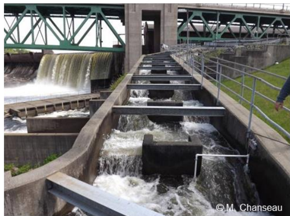
ÉTATS-UNIS 9 : CONNECTICUT – TURNERS-FALLS (suite) : (de haut en bas et de gauche à droite) : vue aérienne de Gate House et du barrage; vue de la passe à bassins (fentes) de Gate House ; vue depuis l'aval de Gate House et des deux entrées ; vue depuis l'amont des deux entrées de la passe de Gate House ; vue de la passe à bassins (Ice Harbor) du barrage.
