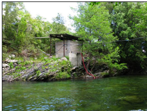
Figure 10 : Pompage individuel dans le lit du Tavignano. 2 juin 2010 . MRM
